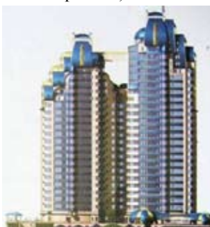
ЖК на вул. Звіринецькій
