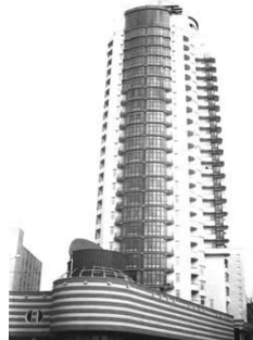
ЖБ на вул. Г. Тимофієвої, 3/13
