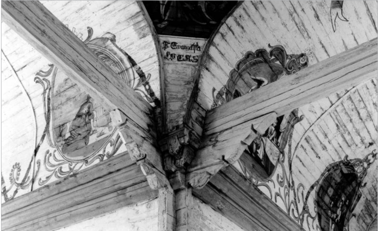
Наріжні балки й консолі нави і трансепта храму в Палтанемі (Paltaniemi), 1726, будівничий Йоган Кнубб. Фінляндія (фото автора, 1993)
