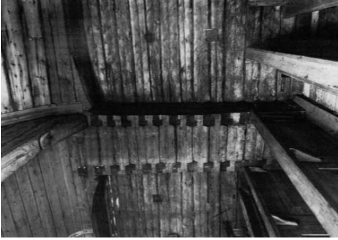
Конструкція зрубного стовпа храму в Вепрі (Vöyri) (рис. Ларса і Ееро Петтерсонів; за: Suomalainen..., dz. сyt. s. 39)
