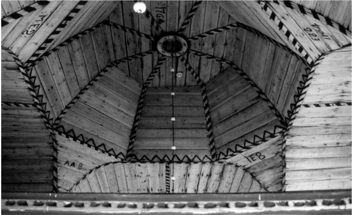
Склепіння бані храму в Петеевеси (Petäjävesi), 1763–1765, будівничий Якко Клеметінпоіка Леппенен. Фінляндія (фото автора, 1993)
