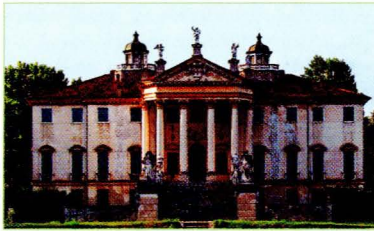
Палладіанство. Архітектор А. Каспарі. Вілла Джованеллі. Кінець XVIII ст. М. Нованта-Падова, Італія
